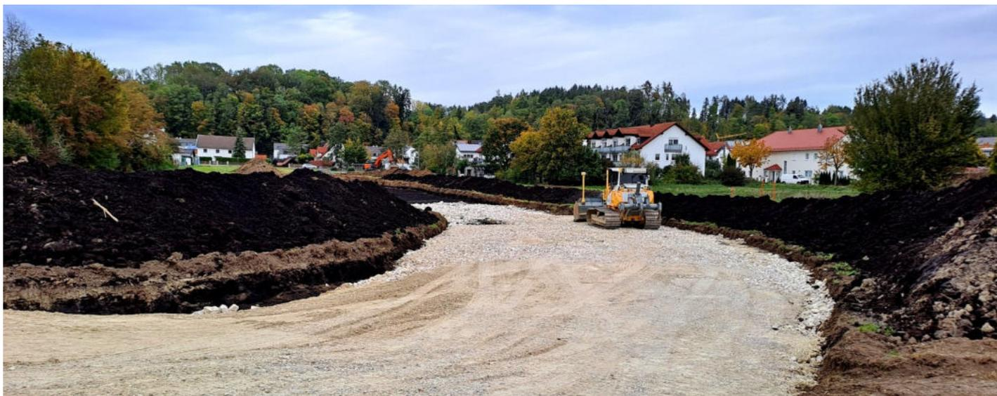
*Die künftige Max-Schneidt-Straße. In den Torf wurden Schroppen eingebracht und anschließend verdichtet. Ein Geotextil und der darauf ausgebrachte Kies bilden weitere Schichten des Straßenunterbaus. Bis zum Frühjahr wird die Baustelle nun ruhen. Die Gemeinderäte befassen sich derzeit in einer Schulung Ende November mit den rechtlichen Rahmenbedingungen für das Einheimischenmodell, mit dem die gemeindlichen Flächen vergeben werden sollen.*
