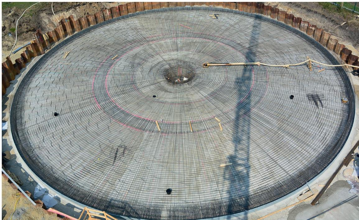
Aus luftiger Höhe vom Kran aus fotografiert sieht das zukünftige Belebungsbecken der Kläranlage mit einem Durchmesser von 30 Metern fast wie ein Kunstwerk aus. Die Eisenflechter haben die Bewehrung für den Bodenplatte geschaffen, als nächstes wird nun betoniert und anschließend die Wände hochgezogen. In die Mitte kommt eine Betonröhre, der sogenannte Königsstuhl, in dem der Klärschlamm, der sich im Becken absetzt, ablaufen kann. Foto: Sigi Voithenleitner
